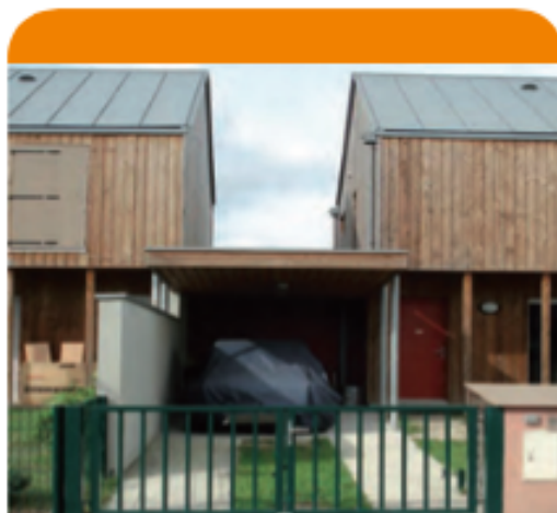
Exemple de place de stationnement couverte non close, Courtry (77) - source : DDT 77, CETE IF, 2013 conception : atelier DA.U (P. Arsène-Henry + P. Dandrel) photo Soazig Friguel 2011
